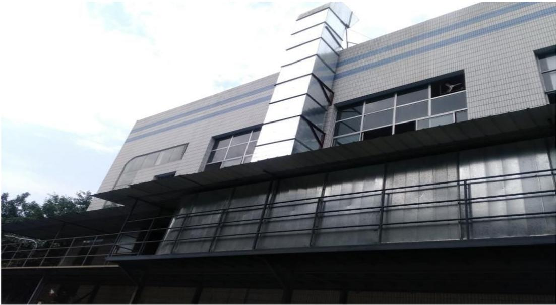
图 6-1 测试废气集气罩和排气筒
